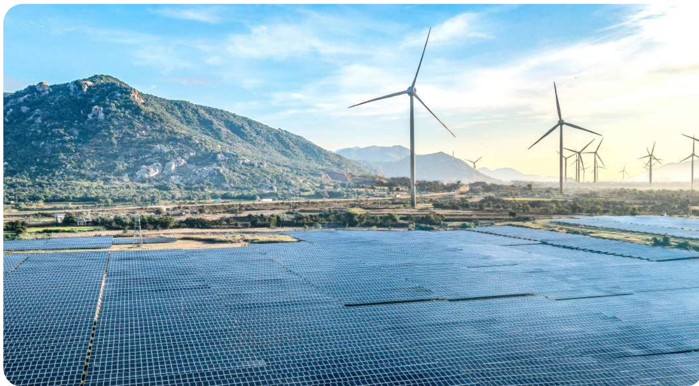
Parque solar fotovoltaico
